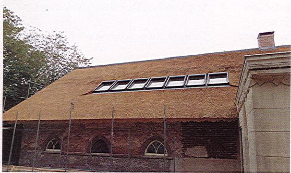
Voor daglichttoetreding is een lichtstraat van dakramen verwezenlijkt.
