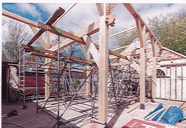
Een beeldbepalende houtconstructie vormt de nieuwe dragende constructie.
