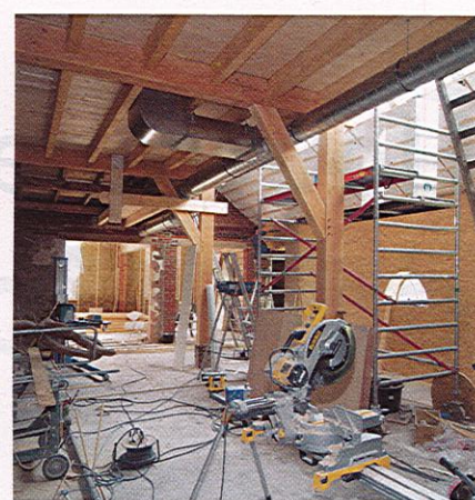
Tussen deze houten constructie worden de ventilatiekanalen gepositioneerd.
