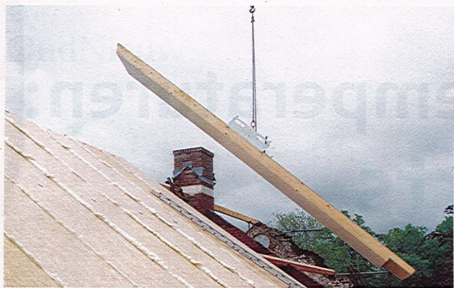
Gevels en dak zijn hoogwaardig geïsoleerd om er een gasloos gebouw met lage temperatuur vloerverwarming van te kunnen maken.
